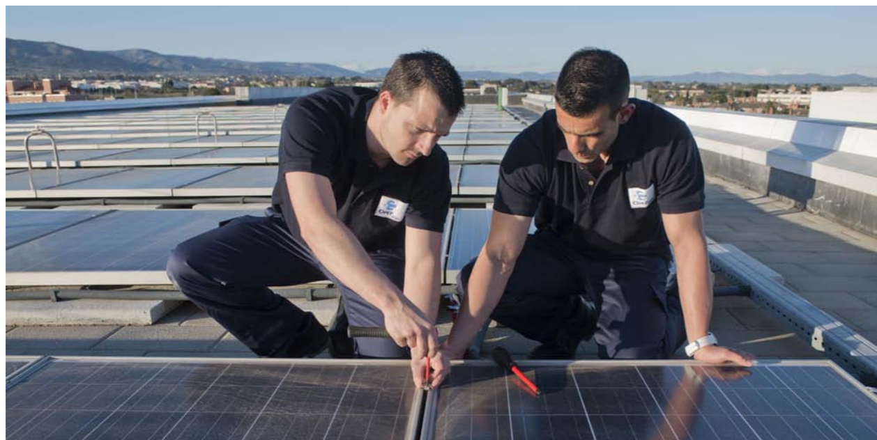
Trabajadores de Clece realizan trabajos de mantenimiento de paneles solares. Hospital Universitari Sant Joan de Reus (Tarragona).
